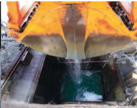
2-4 | Der Greifer hebt pro Arbeitsgang 7,5 Tonnen Material. 5 | Der Sand wird mittels «Schnecken» befördert.
